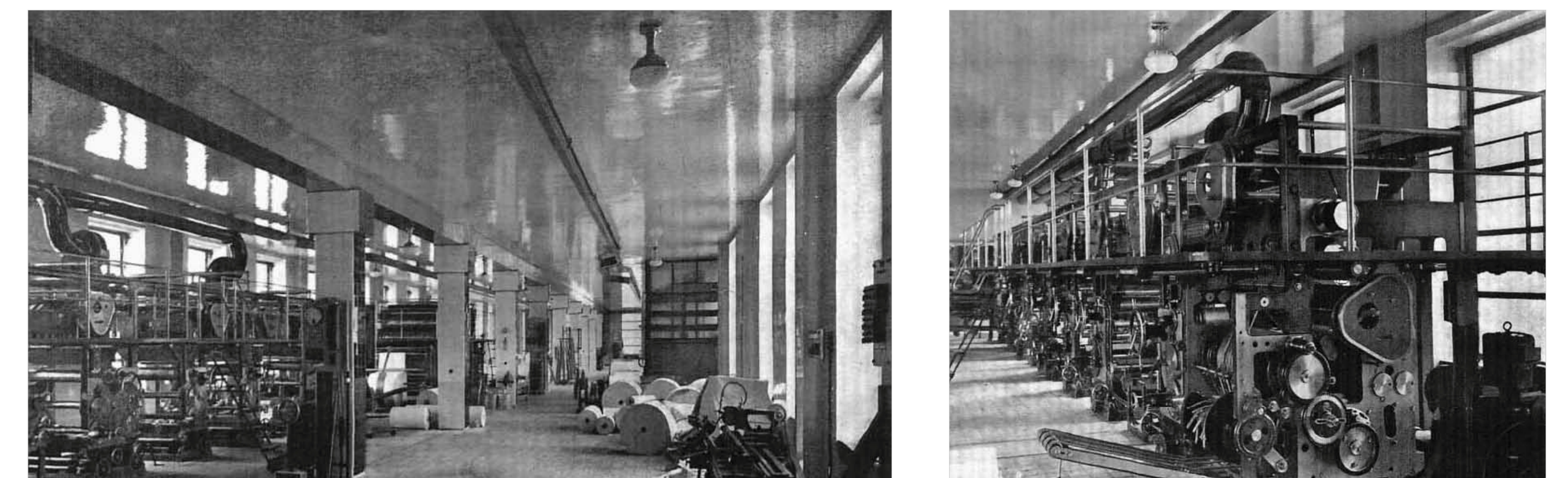
ZDJĘCIA ARCHIWALNE, HALA MASZYN
